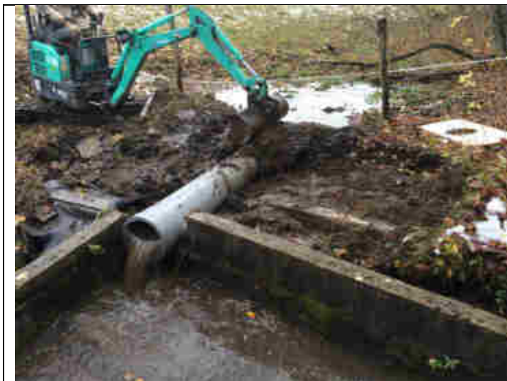
Vue pendant l'aménagement
