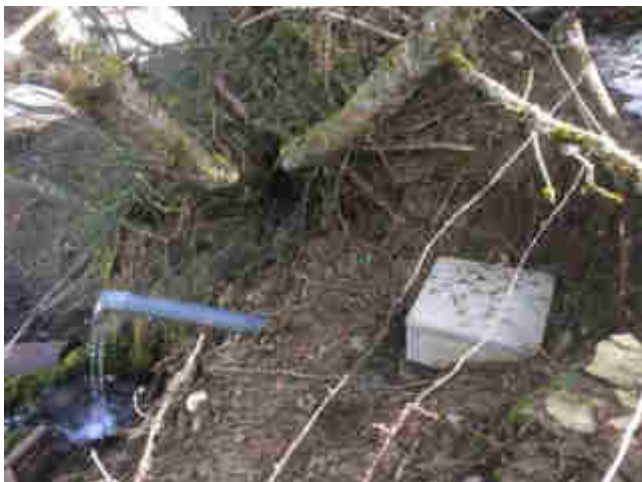
Figure 73 : Vue du captage réhabilité de la source Mermet.
