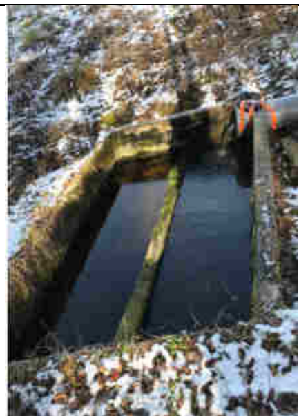
Vue du bac de réception des eaux
