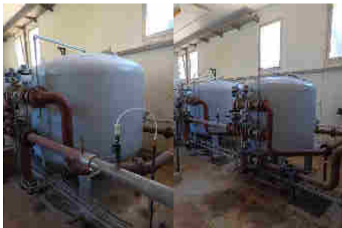
Figure 22 : Photo des cuves de filtration remises en état.
